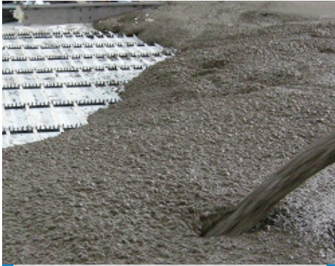
Béton coulé avec l'ajout de Mapefibre NS12 contre le retrait plastique
