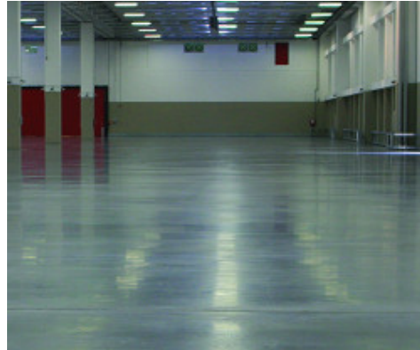
Exemple de sol industriel en béton auquel a été ajouté Mapefibre NS12
